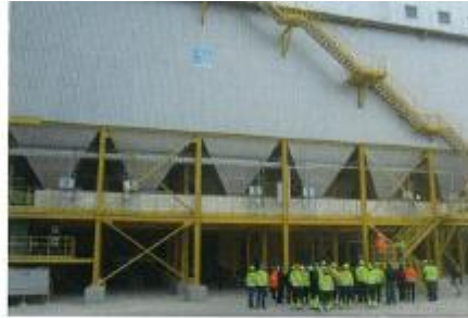
New bag filter at Cementa AB Neue Schlauchfilteranlage bei Cementa AB
